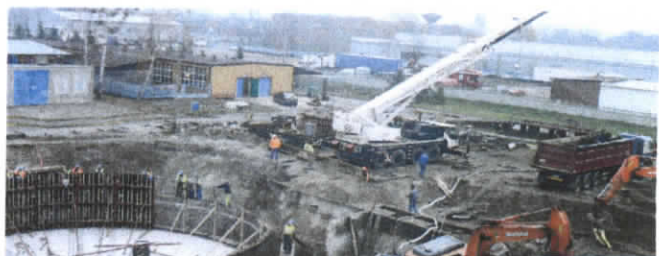
Modernizacja Oczyszczalni Ścieków w Żyrardowie
