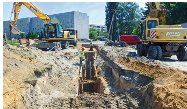
■ Budowa kolektora sanitarnego w ul. Glebowej w Żyrardowie
