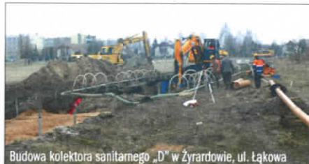
Budowa kolektora sanitarnego „D” w Żyrardowie, ul. Łąkowa
