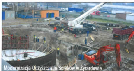
Modernizacja Oczyszczalni Ścieków w Żyrardowie
